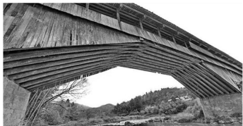
图8 木拱桥的“拱券结构”
